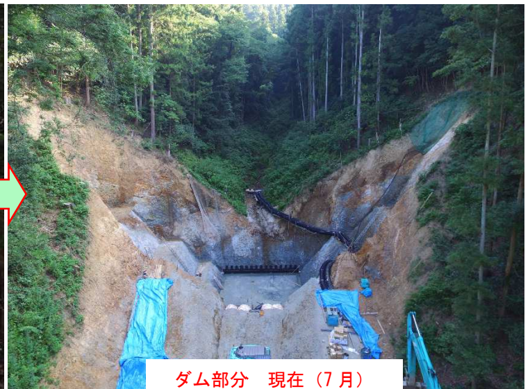
本堤掘削完了(左岸側)
